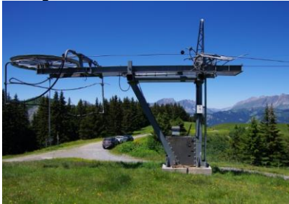
L'arrivée du télésiège de Rochefort: le caractère prégnant des poteaux
