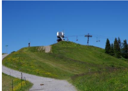
L'arrivée du télésiège de la Petite Fontaine en haut de la butte, le modelé des terrassements, les accès formant un chemin où la terre apparaît, les poteaux forme une butte artificialisée
