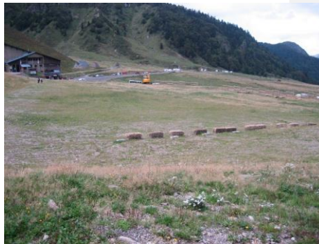
Photo 33 Exemple de mise en place de bottes de paille pour un projet de création de téléski au Mont Dore
