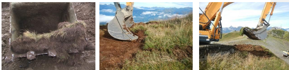
Photo 34 Exemple de déplaçage de mottes à la pelle mécanique et godet « classique »
