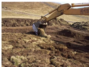
Photo 36 Exemple de remise en place de mottes à la pelle mécanique
