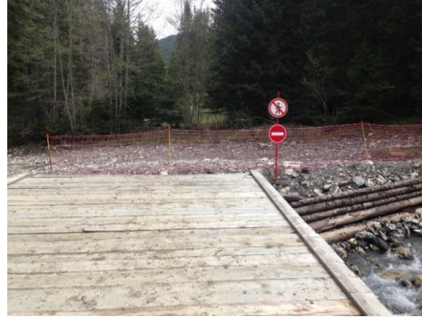
Photo 32 Exemple de passerelles fusibles mises en place sur le torrent du Chon
