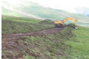
Photo 35 Exemple de stockage de mottes à la pelle mécanique en bordure d'emprise
